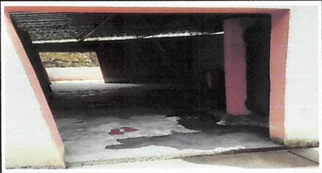
Foto 1. area de cocina no cuenta con drenaje para salida de agua pluvial
